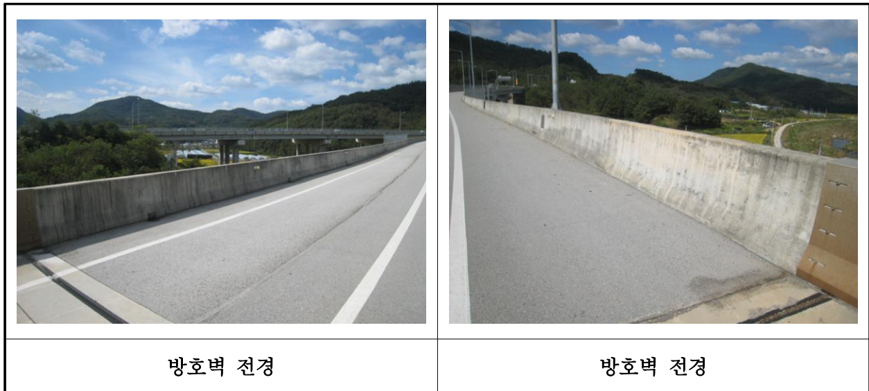
【사진 16.3.23】 방호벽 및 중앙분리대 전경
