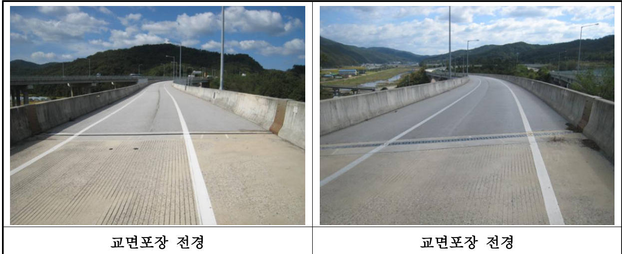
【사진 16.3.19】 교면포장 전경
