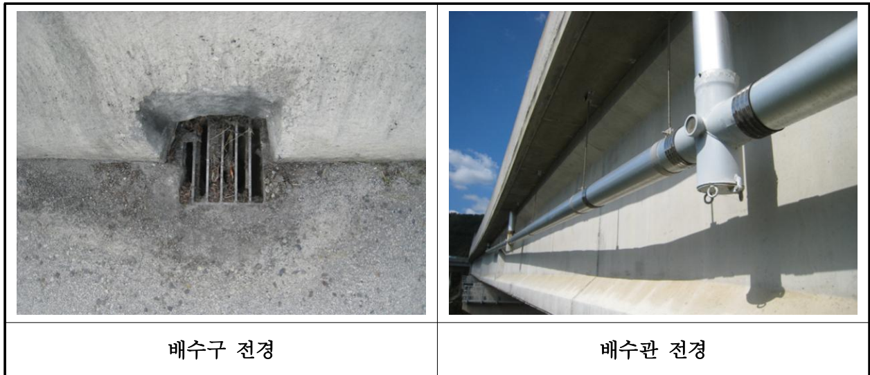
【사진 16.3.21】 배수시설 전경
