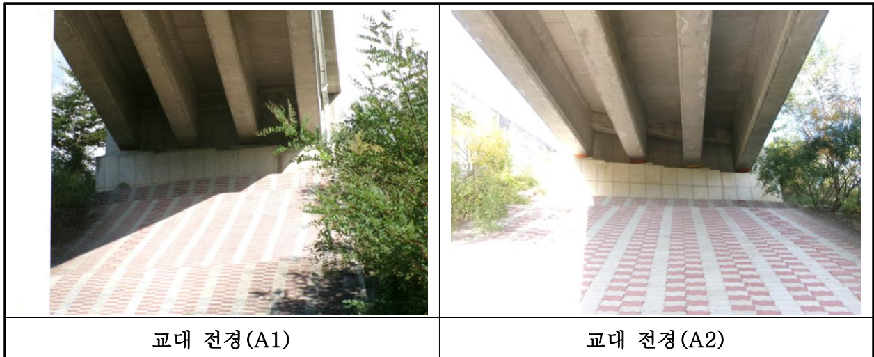
【사진 16.3.8】 교대 전경
