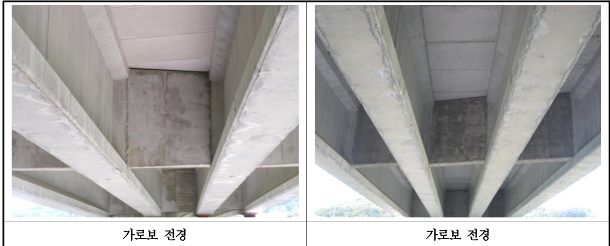
【사진 16.3.6】 가로보 전경
