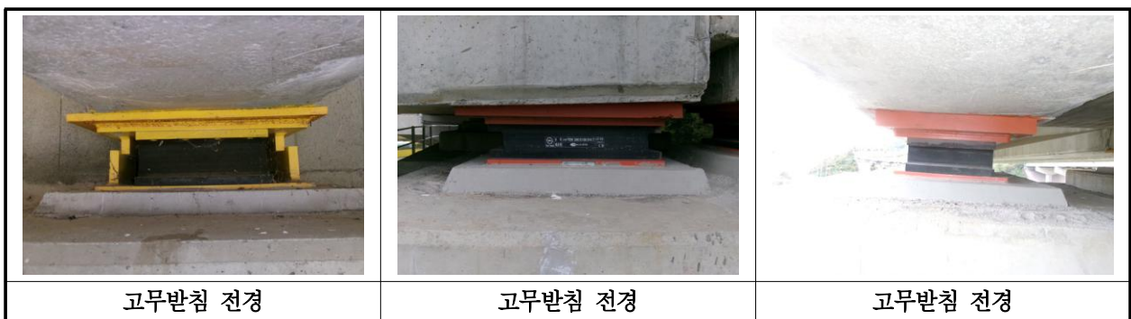
【사진 16.3.12】 교량반침 전경
