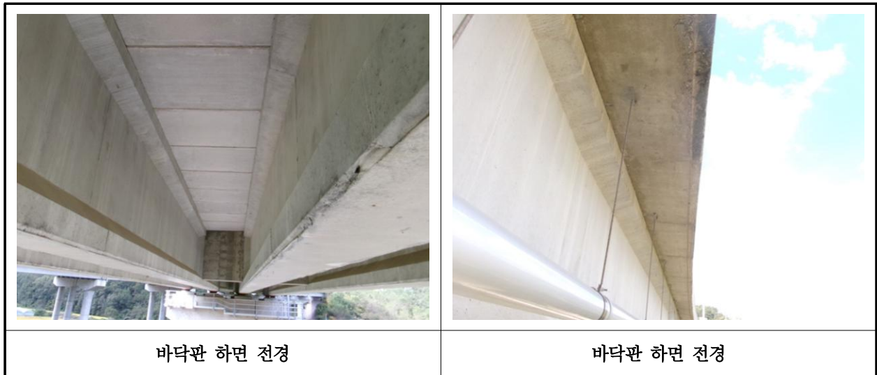
【사진 16.3.2】 바닥판하면 전경
