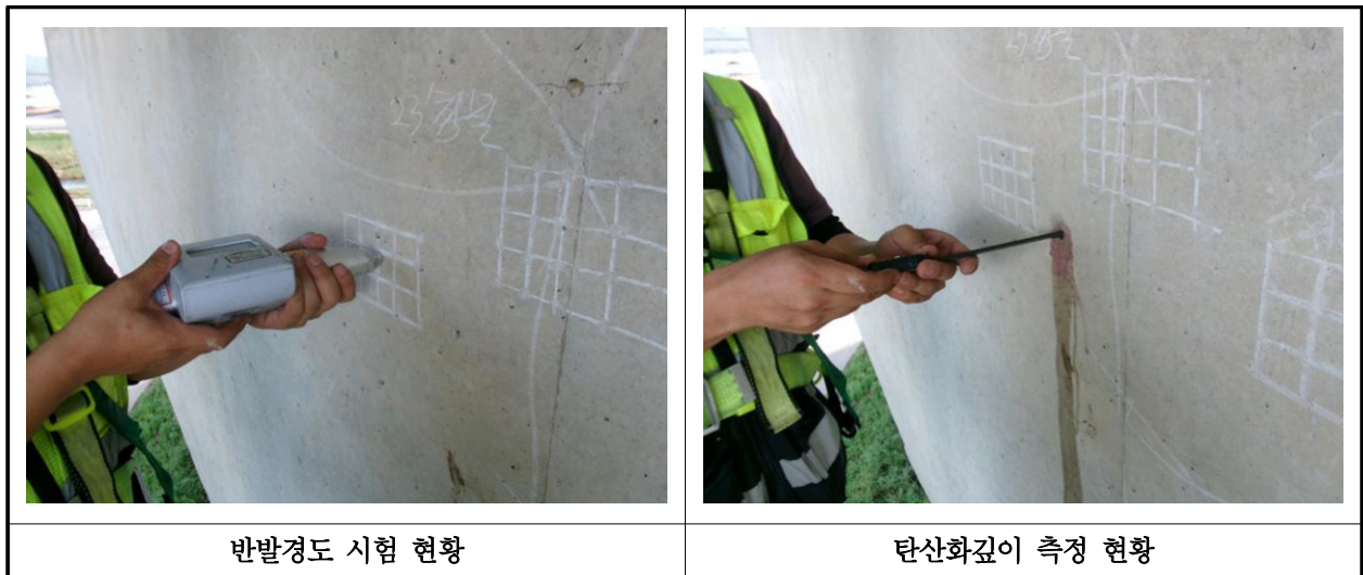
【사진 16.4.1】 콘크리트 내구성조사 현황
