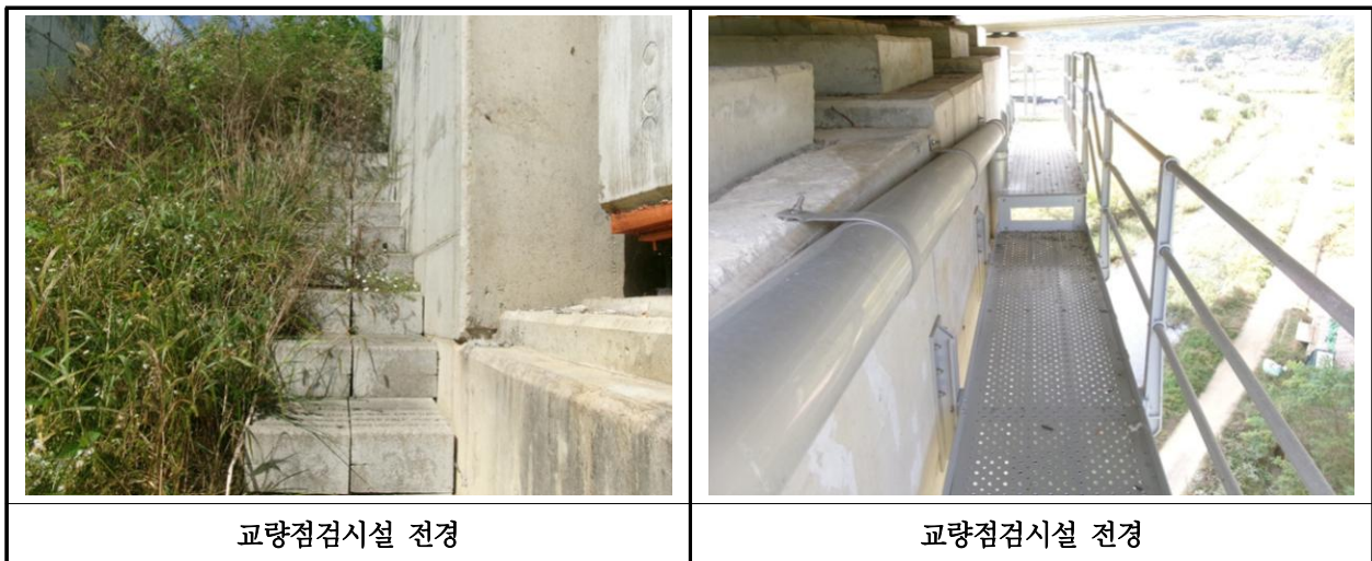
【사진 16.3.25】 교량 점검시설 전경
